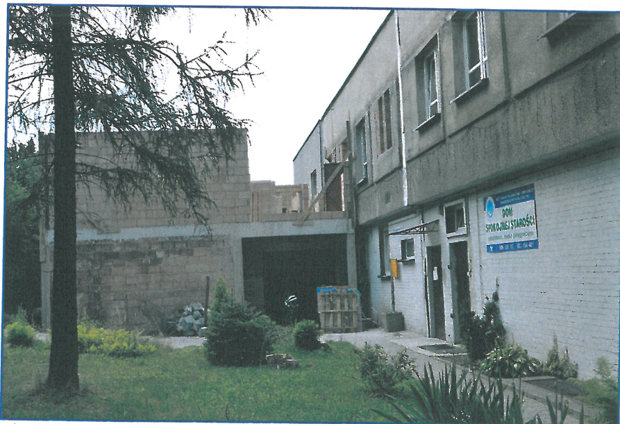
W niepublicznym Zakładzie Pielęgnacyjno-Opiekunczym i Rehabilitacyjnym po zakończeniu remontu pojawi się 17 dodatkowych miejsc
