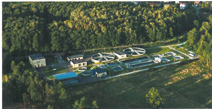
Widok na oczyszczalnię ścieków komunalnych WSCHÓD
